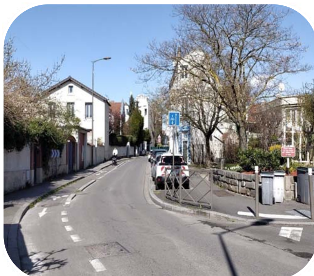
Aménagement cyclable rue du général Leclerc avec contre sens cyclable sur une voie cyclable protégée (Rosny-sous-Bois)
